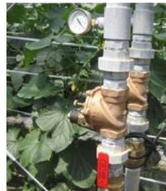
2系統の電磁弁
