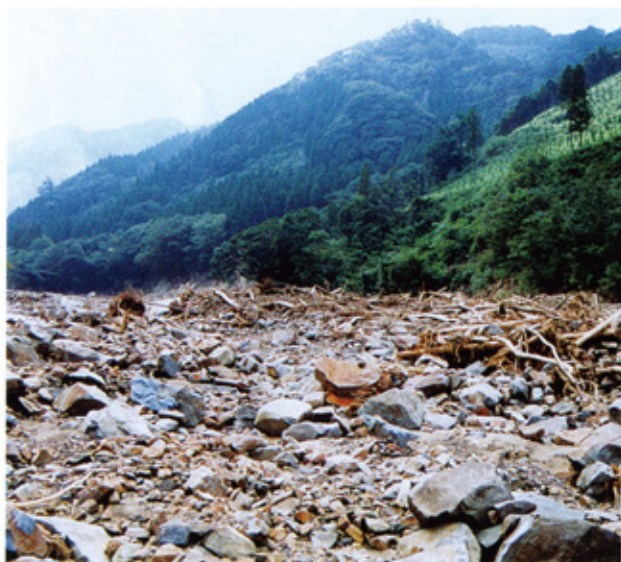
台風14号被災後の天神ダム上流河川の状況
