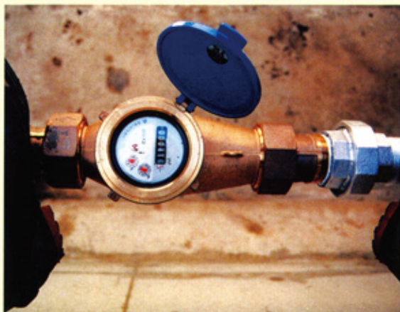
水使用量を測定する水量計
