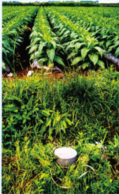
道路きわに設置されているボールバルブ
