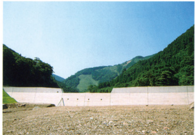
完成した治山堰堤
