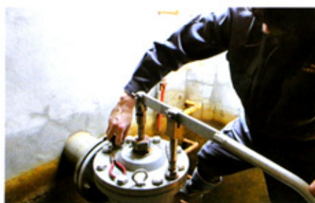
県営施設(ボールタップ弁) の点検状況
