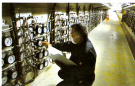
ダム監査室内の 埋設計器の点検
