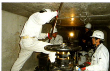
国営施設(減圧弁) の点検
