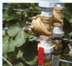
2系統の電磁弁
