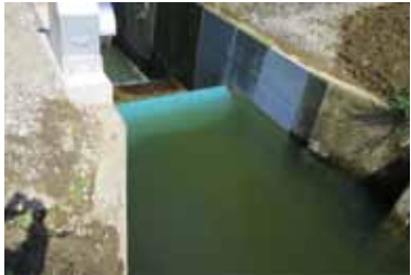
井堰状況写真
