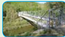
松山川水管橋の塗装工事 (完了)
