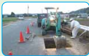
県営造成管水路の漏水工事
