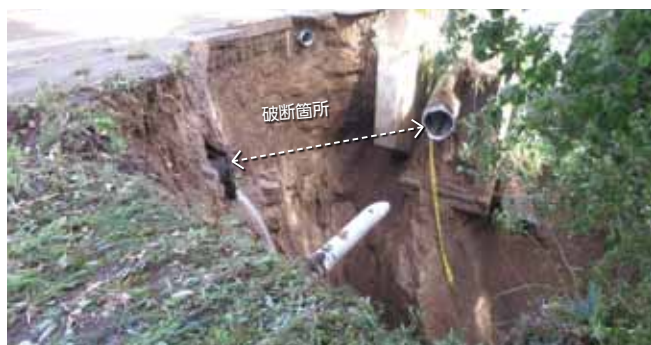
○仮設配管 口径300mm
