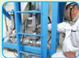
天神ダム放流施設の通常点検
