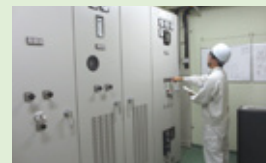
○電気室等(点検作業)
