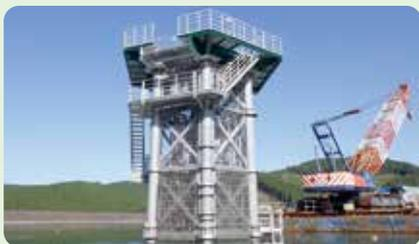
天神ダム上流に土砂流入防止施設建設中（ダムへ土砂が入らないための施設）
