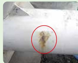
○ダムからの適正な取水管理を行うために地元土地改良区が管理する県営等の管水路の漏水補修工事を地元土地改良区と連携して行っています。
