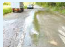
田野町八重地区 （塩ビ管接合部から漏水）
